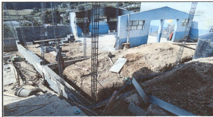
Foto 3: Levantado de pared
