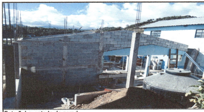
Foto 5: Levantado de pared
