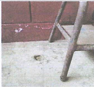
Foto 3: Sustrucción de piso de torta de concreto para el salon 3
