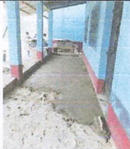
Foto 5: Sustrucción de piso de torta de concreto para el salon 5
