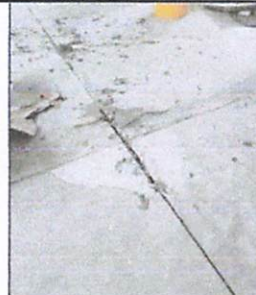
Foto 6: Sustrucción de piso de torta de concreto para el salon 6
