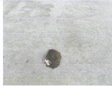
Foto 2: Sustrucción de piso de torta de concreto para el salon 2
