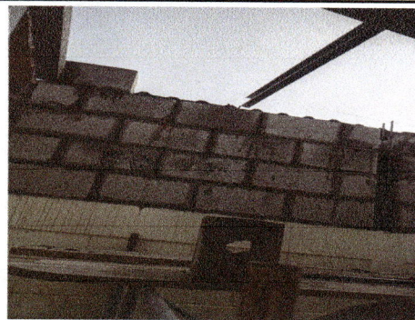
Foto 6: levantado de pared block
