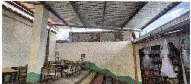
Foto 6: levantado de pared block
