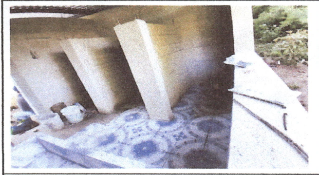
Foto 2: Ampliación de Baños
