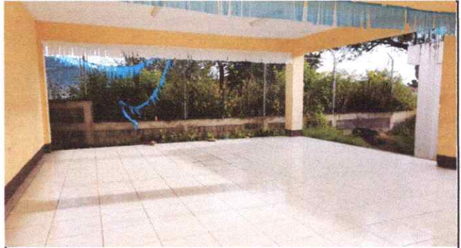
Foto 10: colocación de ventanas y pared.
