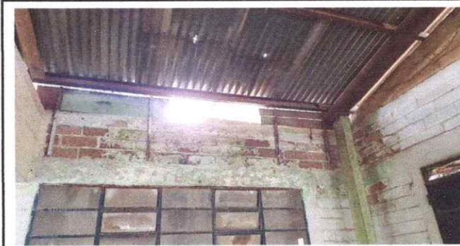
Foto 1: cambios de laminas, costaneras y repello
