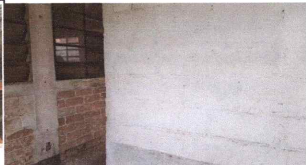
Foto 6: acabado en cocina (Repello)
