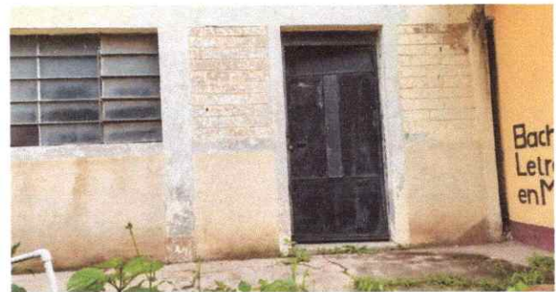
Foto 4: Fabricación de una puerta. Pavimento, gradas y repello.
