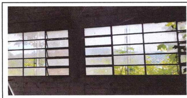
Foto 11: mantenimiento, cambio de vidrios y pintada de ventas
