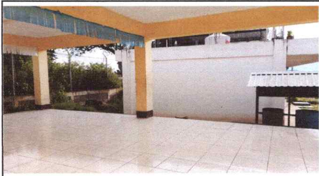
Foto 7: levantados de pared, repello y sernido y colocación de ventanas. Salon de usos multiples.
