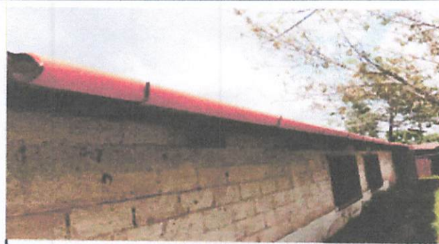
Foto 9: sustitución de canal pvc
