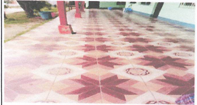
Foto 8: sustitución de piso de granito
