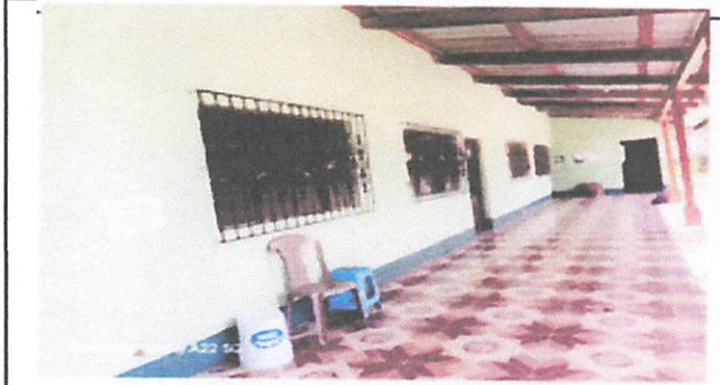
Foto 10: pintura en muros exteriores e interiores
