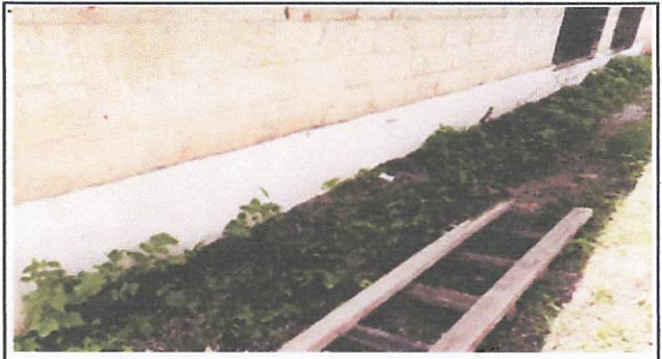
Foto 2: impermeabilización de loza de computación
