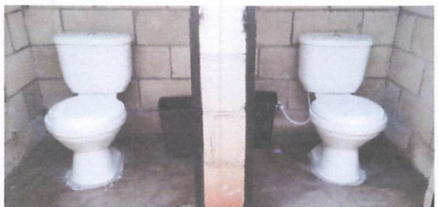
Foto 11: Sustitución de inodoro
