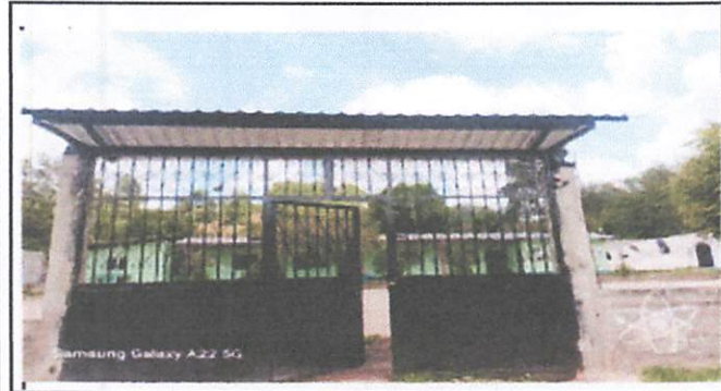
Foto 1: Sustrucción de estructura de soporte de madera por metal, se realizo un cambio por la sombra del porton principal. Consta acta No. 16-2024
