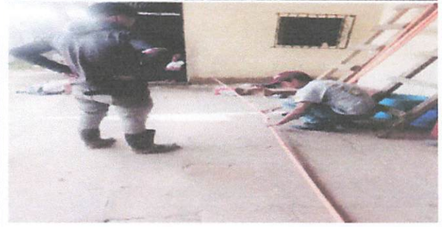
Foto 14: Sustitución de ducto eléctrico
