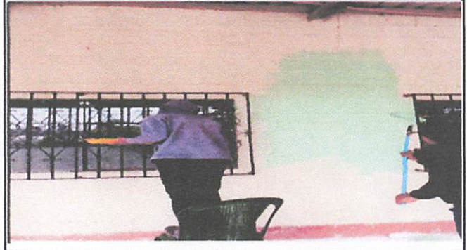
Foto 10: pintura en muros exteriores e interiores
