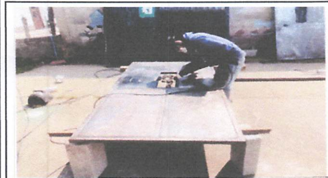
Foto 3: Mantenimiento de estructura
