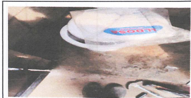
Foto 11: Sustitución de inodoro
