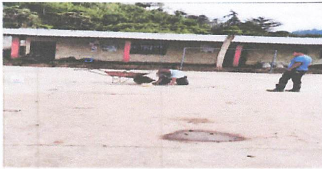
Foto 13: Reparación deplancha de concreto de patio
