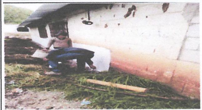
Foto 2: impermeabilización de loza de computación
