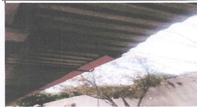
Foto 9: sustitución de canal pvc
