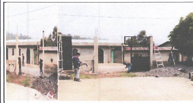
Foto 5: Sustrucción de porton de metal
