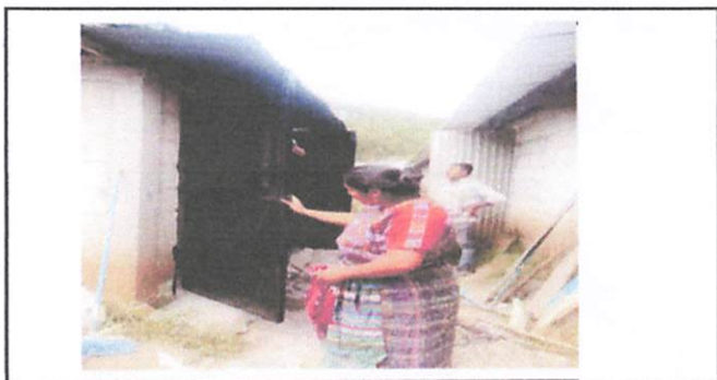
Foto 6: sustitución de puerta de madera a metal
