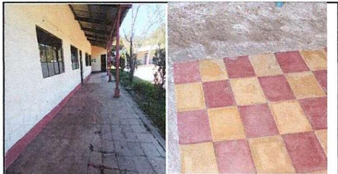
Foto 8: sustitución de piso de granito.
