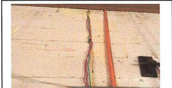
Foto 14 : Sustitución de ducto electrico + accesorios
