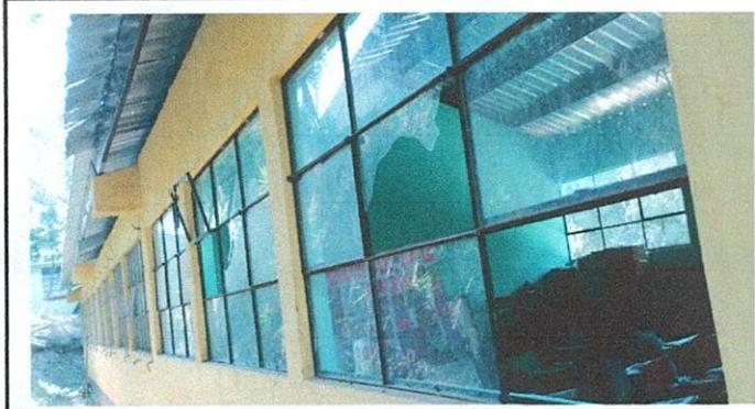
Foto 1: Se observa el deterioro de los vidrios de algunas ventanas en la parte de atrás de las aulas, se colocará los vidrios que hacen falta y 12 balcones.
