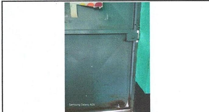
Foto 3: Se observa el deterioro de la puerta del aula No. 1, se reparará, pintará y se sustituirá chapa.
