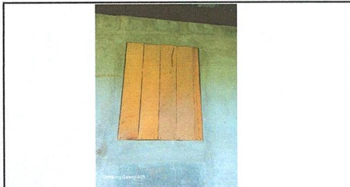
Foto 3: Se observa ventana de madera en bodega, se sustituirá por ventana de metal con vidrios, por seguridad.
