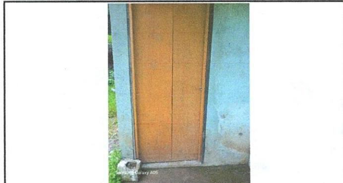
Foto 4: Se observa puerta de madera en bodega, se sustituirá por puerta de metal con pasador.
