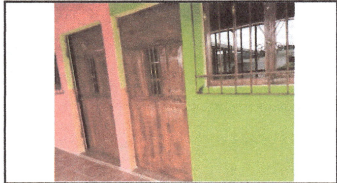
Foto 2: Se colocaron las puertas de metal a los salones.
