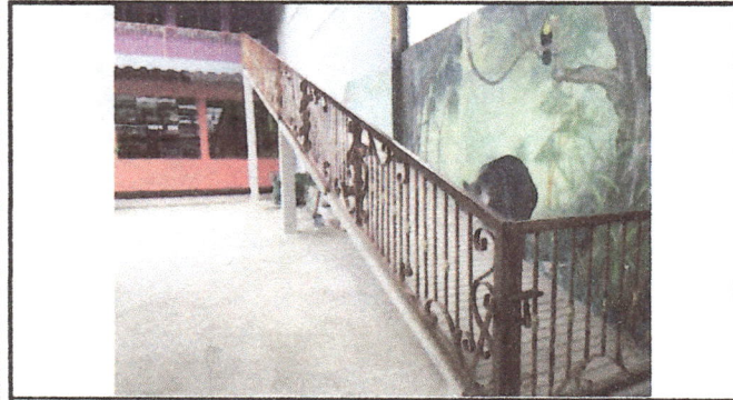
Foto 1: Se colocó pasamanos en toda la rampa.
