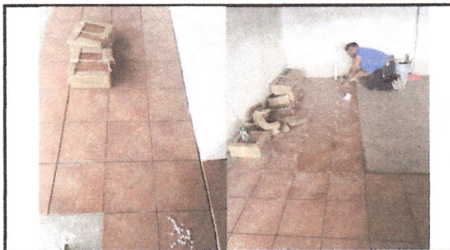
Foto 4: Se colocó el piso cerámico en tres salones.
