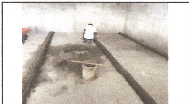
Foto 3: Se fundió en contrapiso para tres salones.
