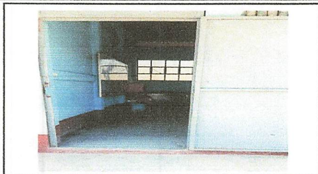
Foto1: lijado y pintura de puertas.
