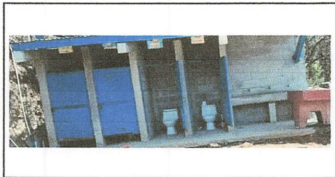
Foto 5: pintado de pared de sanitarios.
