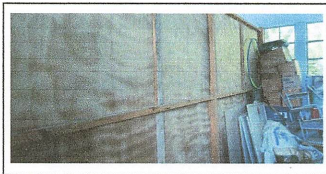
Foto 6: sustitución de división de salones.
