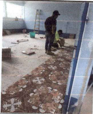
Foto 9: Instalación de piso cerámico
