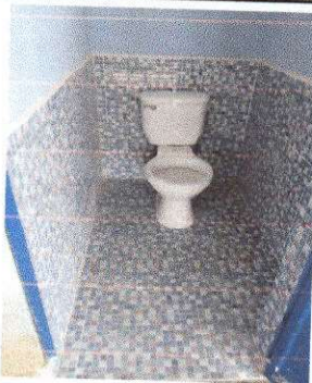
Foto 5: Sanitario, desmontaje e instalacion es de nuevos.
