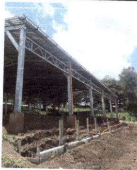
Foto 11: Canales, pescantes y bajadas pluviales.
