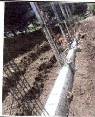
Foto 10: Muro de contención
