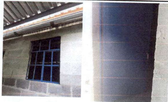
Foto 12: Puertas y ventanas de cocina.
