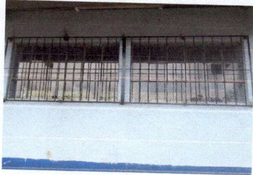
Foto: Sustitución de vidrios
