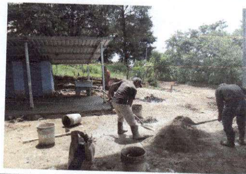
Foto 6: Banqueta de concreto de sanitario.
