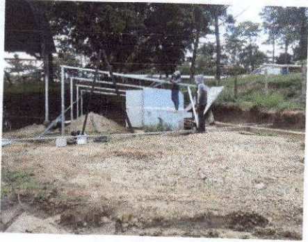
Foto 1: Estructura de Techo de sanitario.
