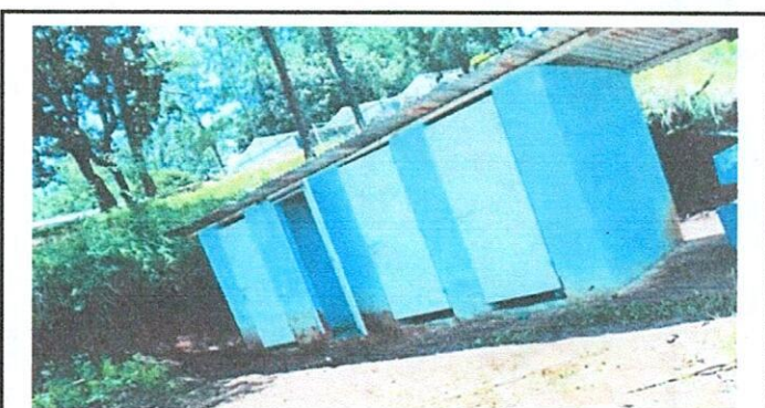
Foto 6: Banqueta de concreto de sanitarios.
