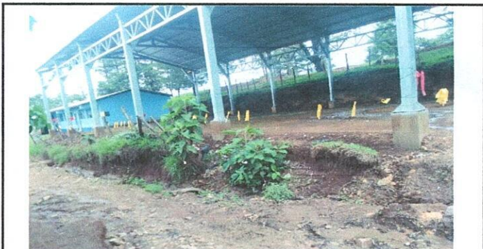
Foto 10: Muro de contención
