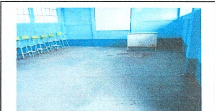
Foto 9: Instalación de piso cerámico
