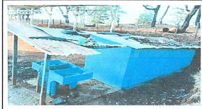
Foto 1: Estructura de Techo de sanitarios.
