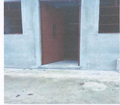
Foto 2: Finalización de construcción de cocina
