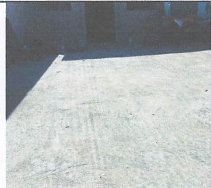
Foto 4: Finalización de Pavimento de concreto entrada principal
