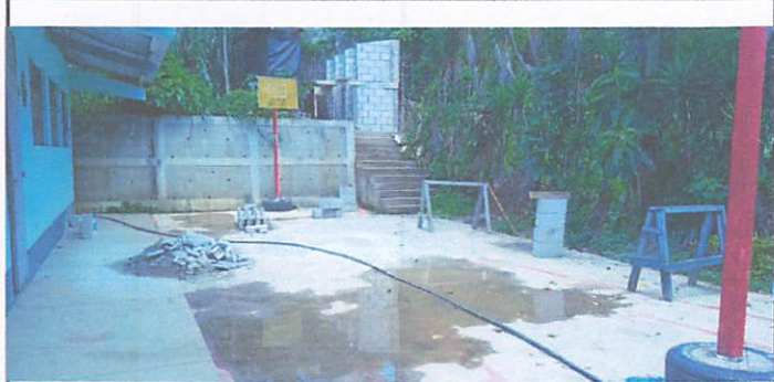
Foto 3: Reposición de área de cancha deportiva
