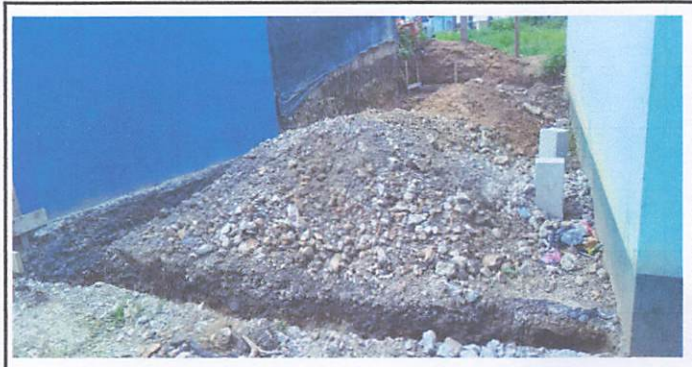
Foto 2: Remodelación de cocina
