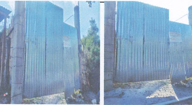
Foto 3: Porton y pavimentacion de entrada principal
