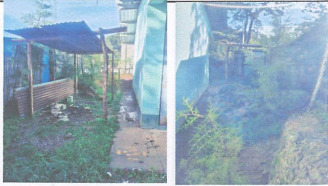
Foto 1: Construccion de cocina
