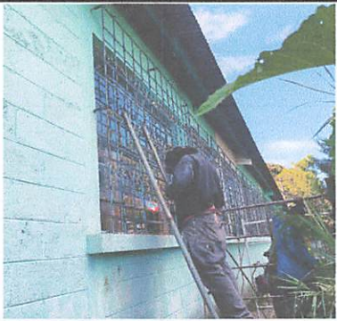
Foto 5. Mantenimiento de estructura de metal de ventanas.
