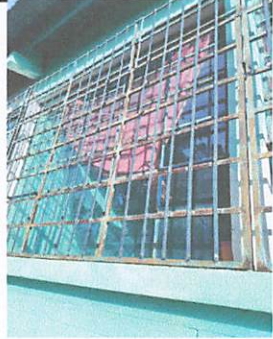
Foto 6. Mantenimiento. Y Reforzamiento de Balcones.
