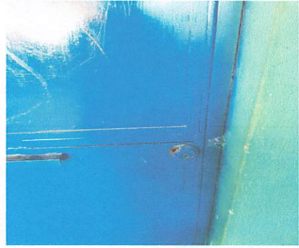
Foto 4: Sustitución de chapa Vera por Chapa Yale.
