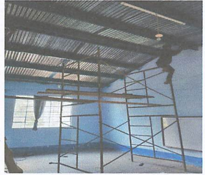
Foto 2. Mantenimiento de estructura de soporte de metal.
