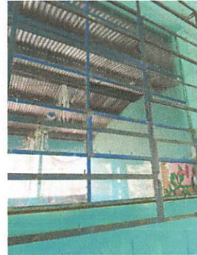
Foto 4: Mantenimiento de balcones de metal
