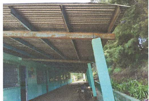
Foto 2: Mantenimiento de soporte de estructura de metal
