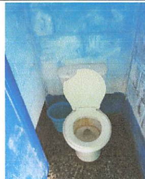
Foto 6: Sustitucion de accesorios de inodoro ( tapadera)
