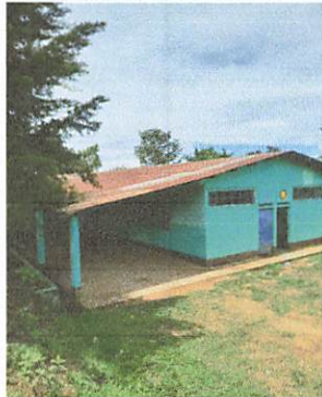
Foto1: Sustitucion de lamina troquelada Aluzinc calibre 26
