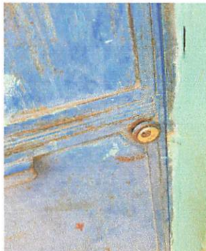
Foto 3: Mantenimiento de estructura de metal lijado y aplicación de pintura. Sustucion de chapa
