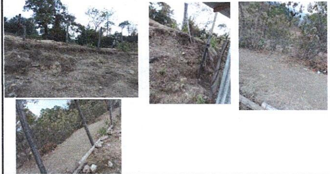
Foto 2: Circulación cambio de malla por construcción de pared de block y malla
