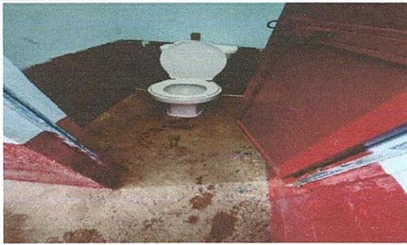
Foto1: Esta es una muestra del estado en que estan, por lo que se requiere cambiar piso y colocarle azulejo a los mismos.
