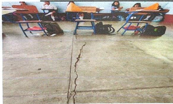
Foto 5: se quiere colocar ceramico y quitar la torta ya que se ve en mal estado nuestro piso.
