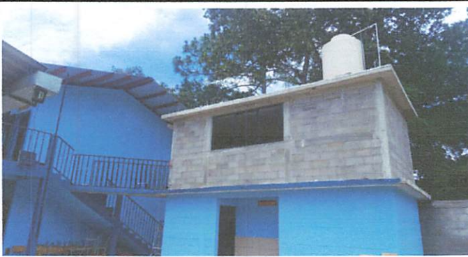
FOTO 3: LEVANTADO DE PARED PARA COCINA TERMINADO
