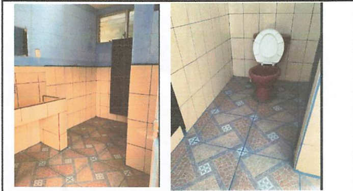
FOTO 9: COLOCACION DE PISO Y AZULEJO EN SANITARIOS
