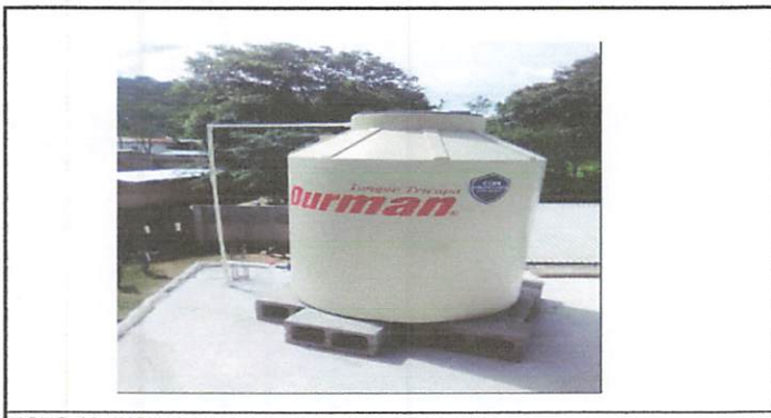
FOTO 11: INSTALACION DE DEPOSITO DE AGUA
