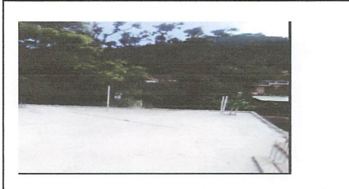
FOTO 10: BASE DE CONCRETO TERMINADA
