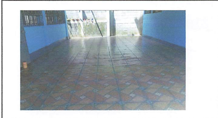
FOTO 8: PISO EN CORREDORES
