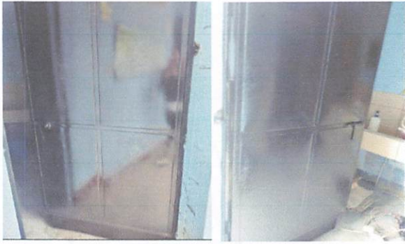
FOTO 1: PUERTAS DE SERVICIOS SANITARIOS
