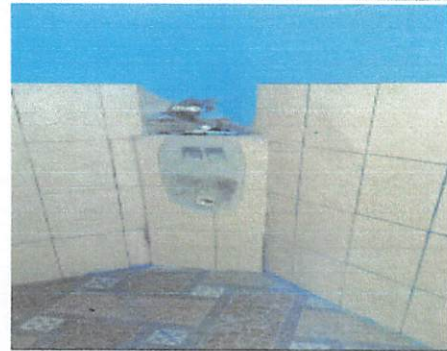
FOTO 12: INSTALACION DE MINGITORIO
