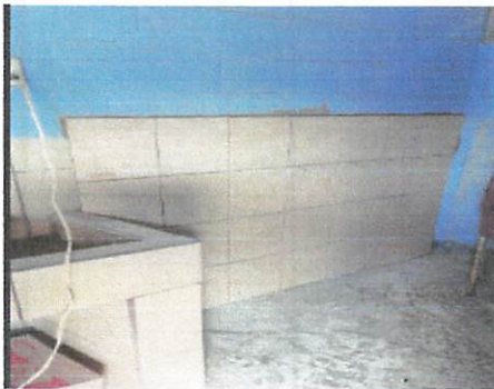
FOTO 9: COLOCACION DE PISO Y AZULEJO EN SANITARIOS
