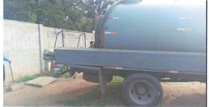
FOTO 2: LIMPIEZA DE FOSA SEPTICA
