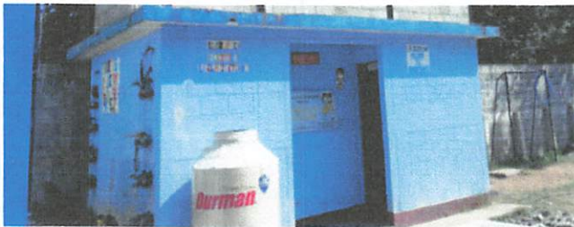
FOTO 11: INSTALACION DE DEPOSITO DE AGUA
