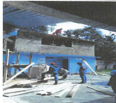
FOTO 10: INSTALACION DE BASE CONCRETO
