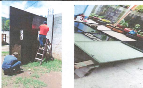
FOTO 5: MANTENIMIENTO A PORTON
