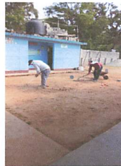
FOTO 4: COLOCACION DE ADOQUIN EN PATIO
