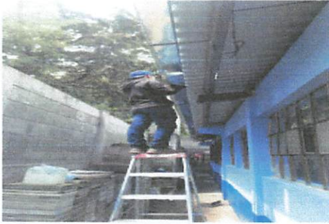
FOTO 7: COLOCACION DE CANAL
