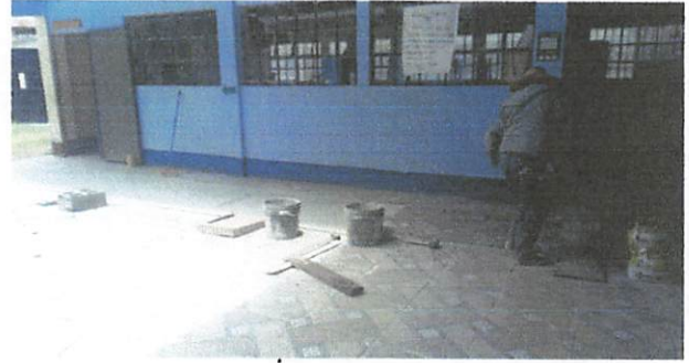
FOTO 8: COLOCACION DE PISO EN CORREDORES
