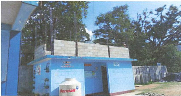
FOTO 3: LEVANTADO DE PARED PARA COCINA
