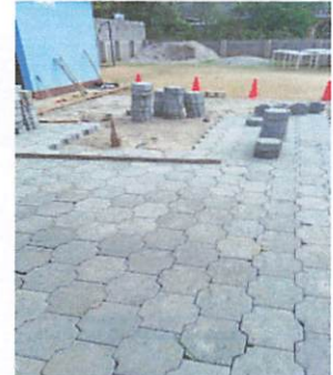
FOTO 4: COLOCACION DE ADOQUIN EN PATIO
