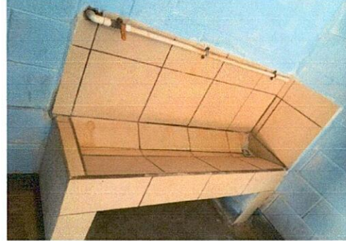
Foto 8: sustitución de mingitorio, ya que no es funcional
