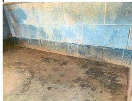
foto 6: repello y pintura en algunas paredes
