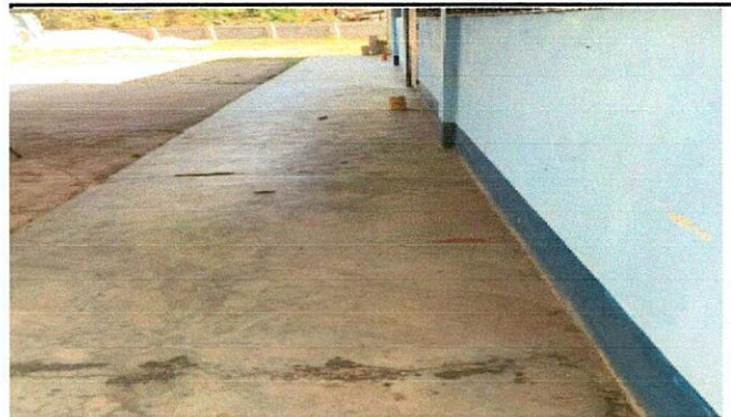
Foto 4: torta de concreto mal estado
