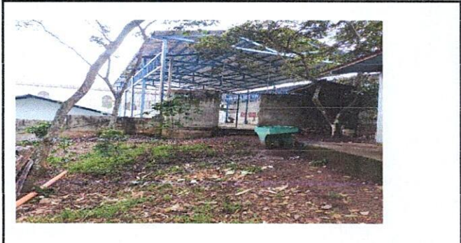
Foto 2: Construcción de batería de tres baños, drenaje y fosa septica
