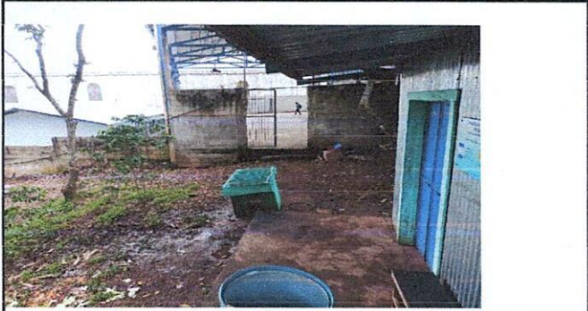
Foto 1: Construcción de drenaje para uso de la cocina.
