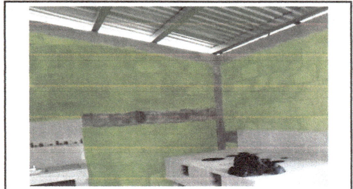
Foto 4: Techo de cocina terminado.
