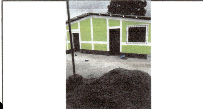
Foto 1: Terminación de la ampliación de cocina
