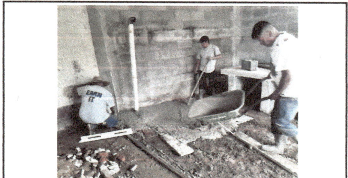
Foto 6: Reparación de base para el piso de cocina
