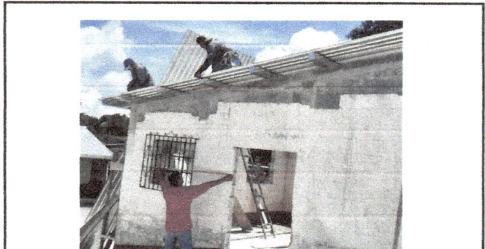
Foto 4: Cambio de techo de cocina.
