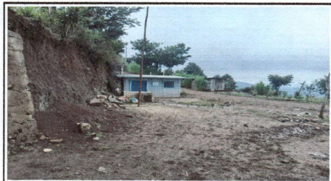
Foto 4: Torta (piso) - drenaje.
