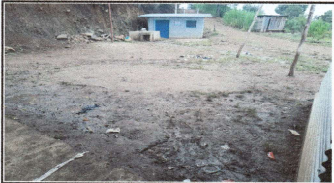
Foto 3: Torta (piso) - drenaje.
