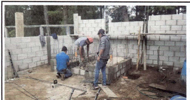
Foto 6: Construcción de pila
