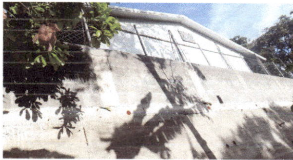
Foto 3: Finalización de la construcción del muro de contención
