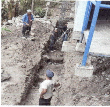
Foto 1: Inicio de los trabajos en el muro de contención
