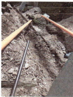
Foto 5: Inicio de la colocación de la tubería de drenaje
