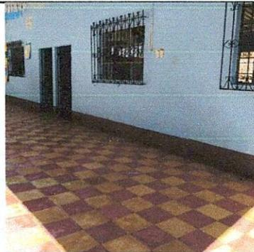
Foto 2: Se necesita el cambio de piso de cerámica debido al deterioro del mismo.
