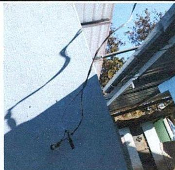
Foto 3: es necesario colocar una caja de flipones para mejorar el cableado eléctrico.
