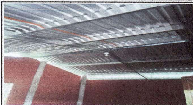
Foto 2: TECHADO, INSTALACION ELECTRICA Y PINTURA
