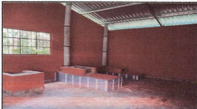
Foto 3: PLANCHAS, MOLENDERO, CHIMENEAS
