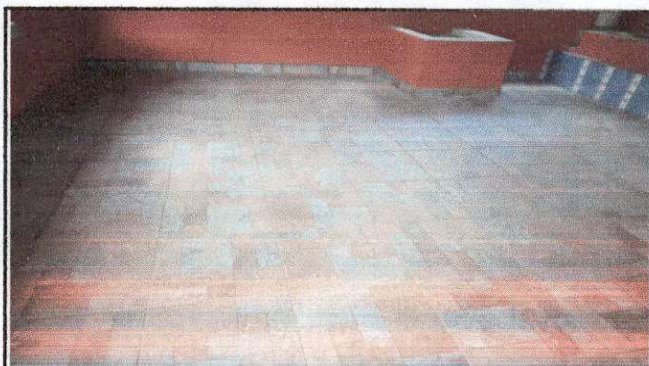
Foto 4: PISO DE COCINA TERMINADO
