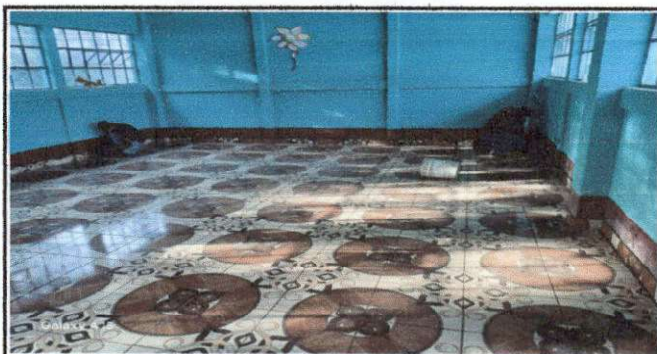
Foto 5: PISO DE AULAS
