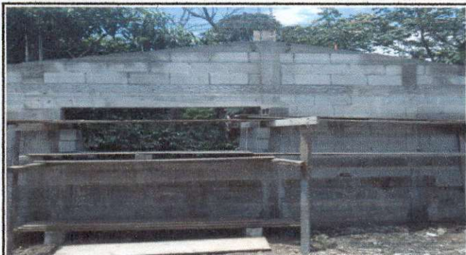
Foto 1: PAREDES DE COCINA
