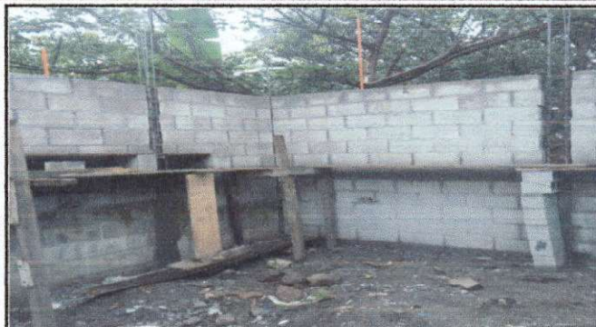
Foto 2: PAREDES DE COCINA
