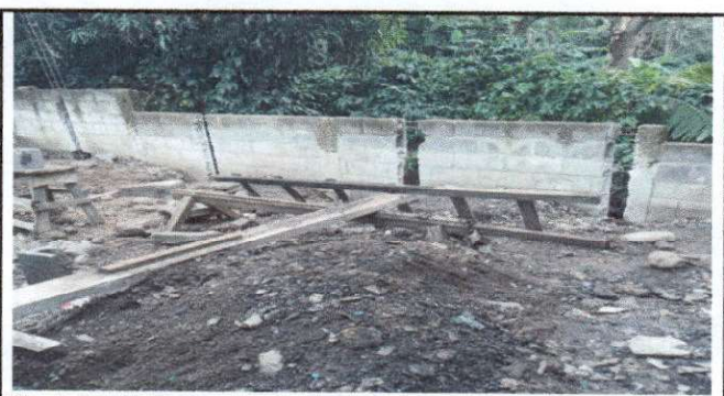
Foto 5: PAREDES DE COCINA
