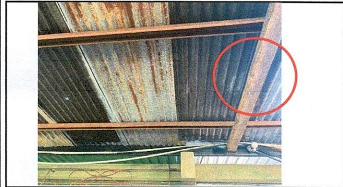
**Foto 3:** Cambio de vigas de madera por apollillado dentro de su estructura
