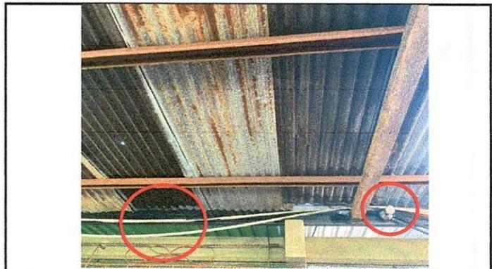
**Foto 4:** Cambio de tubería de instalación eléctrica
