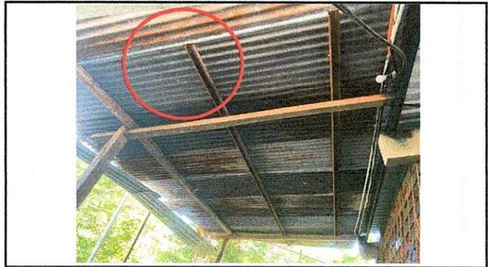
**Foto 2:** Cambio de laminas por oxidacion de techo y costaneras.
