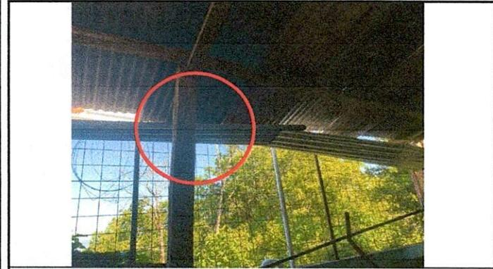
**Foto 1:** Cambio de estructura de madera por apollillado de los parales.
