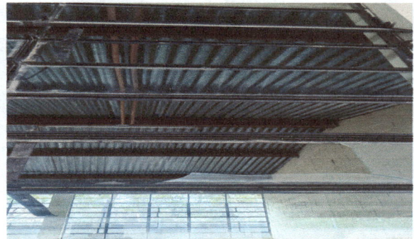
Foto 4: Cambio de 92 piezas de vidrios quebrados de 3 salones de clases, de 1 pie cada uno e instalación de 30 m2 de balcones de 3 salones de clases.
