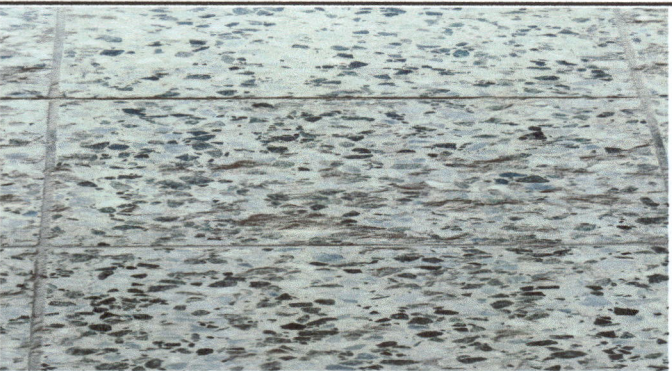
Foto 3: Construcción de 227 m2 de base de concreto de 6 cm para instalación de 227 m2 de piso cerámico en 3 salones de clases y corredor.
