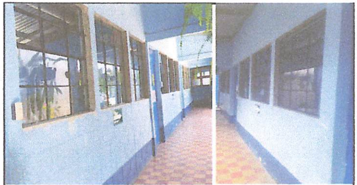
Foto 6: suministro, fabricación e instalación de ventanas de metal con vidrio transparente de 5mm con medidas de 1.35m x 1.13m para sustitución de ventanas de madera en salones
