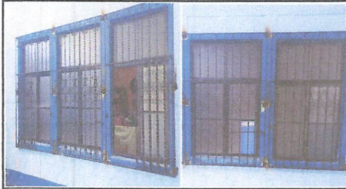
Foto 9: Suministro, fabricación e instalación de balcones de metal corredizos con medidas de 1.60m x 1.13m para seguridad en cocina.
