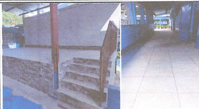
Foto 13: Sustitución de piso de torta de concreto x piso cerámico antideslizante + fachaleta en corredor y escenario
