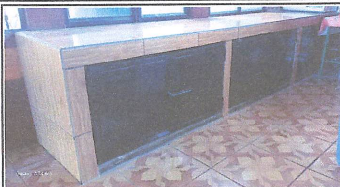
Foto 14: Suministro, fabricación e instalación de puertas de metal de dos bandas para gabinete de concreto en cocina
