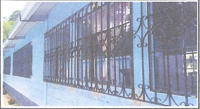
Foto 8: Suministro, fabricación e instalación de balcones de metal con medidas de 1.50m x 1.25m para seguridad en salones
