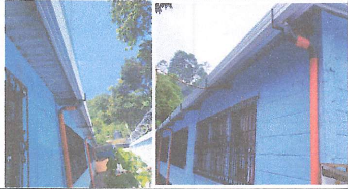
Foto1: Suministro e instalación de 27 metros de canal de metal calibre 26" con soporte y bajadas de agua
