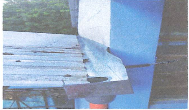
Foto 2: Suministro e instalación de 7 metros de canal de metal calibre 26" con soporte y bajadas de agua
