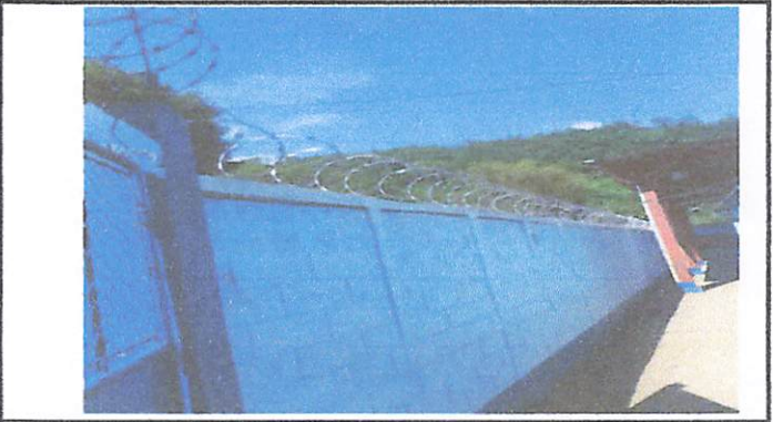
Foto 10: MUROS PERIMETRALES instalación de razor(cerco de alambre de púa) de acero inoxidable rollo de 10 ML
