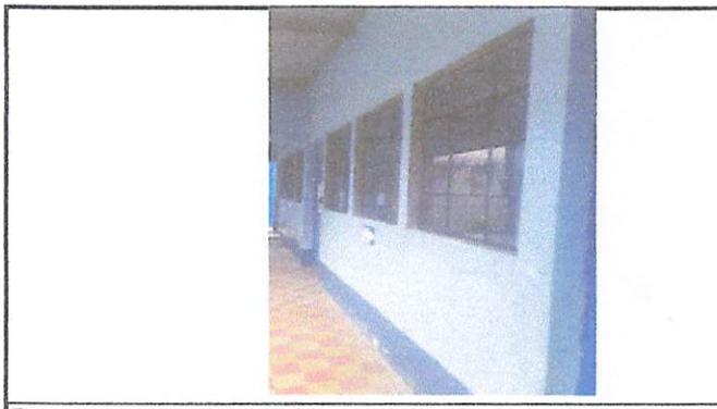
Foto 6: suministro, fabricación e instalación de ventanas de metal con vidrio transparente de 5mm con medidas de 1.35m x 1.13m para sustitución de ventanas de madera en salones
