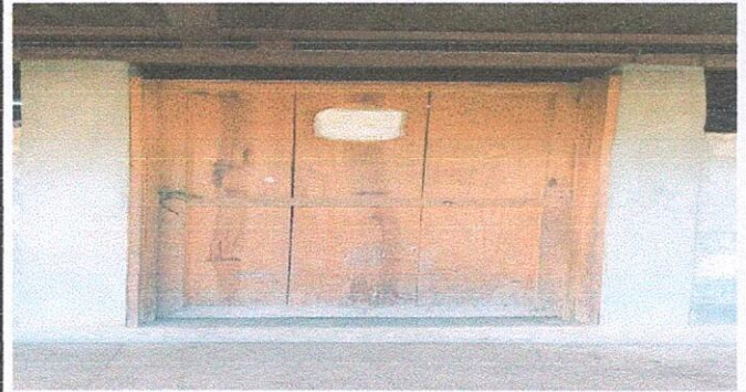
Foto 2: Para seguridad de la cocina se cambiará puerta de madera a puerta de metal con chapa.
