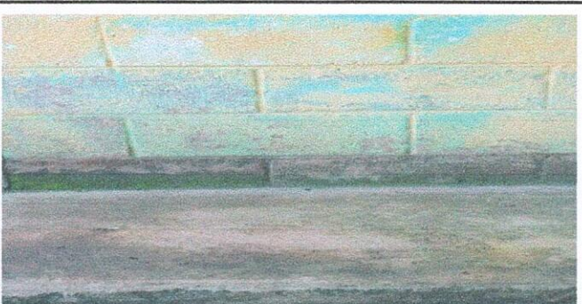
Foto 5: Socalo; se observa el deterioro de pintura del socalo, por lo tanto se cambiará por socalo de cerámica.
