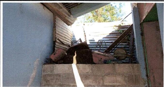
Foto 15: Se necesita finalizar el muro para evitar la entrada de tierra y lodo en las intalaciones.
