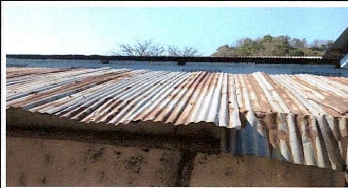
Foto 13: Debido al mal estado del techado en sanitarios, se necesita la intalacion de lamina troquelada.
