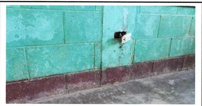
Foto 18: Intalación de tomacorrientes en dos salones, por deterioro y mala conexión.
