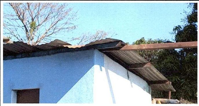
Foto 14: La estructura portante de metal se encuentra desajustada y en mal estado, por ello se necesita el cambio e intalación de la misma.
