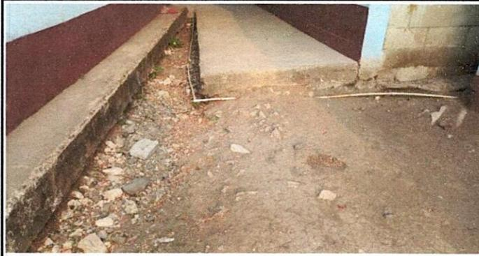
Foto 19: se necesita cubrir con torta de cemento en patio de salón y sanitarios.
