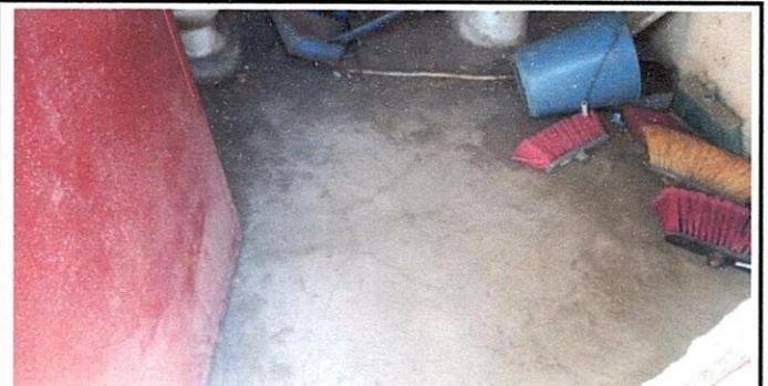
Foto 12: Debido al deterioro de tortas de cemento en sanitarios, se necesita la colocación e instalación de piso antideslizante.
