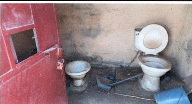
Foto 9: Se necesita la Fundición de módulo de migitorio, tipo pileta, debido a la cantidad de niños existentes en la escuela.
