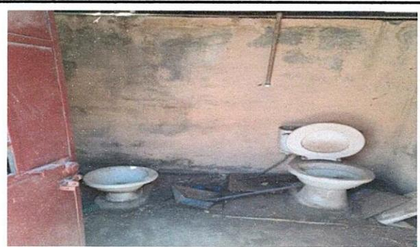
Foto 10: Debido al deterioro de las tazas de inodoros se necesita el cambio de las mismas.
