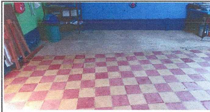
Foto 3: Sustitución de piso ladrillo de color por cerámica en aula de cuarto
