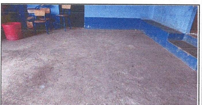
Foto 6: Colocación de piso cerámico enfrente de cocina
