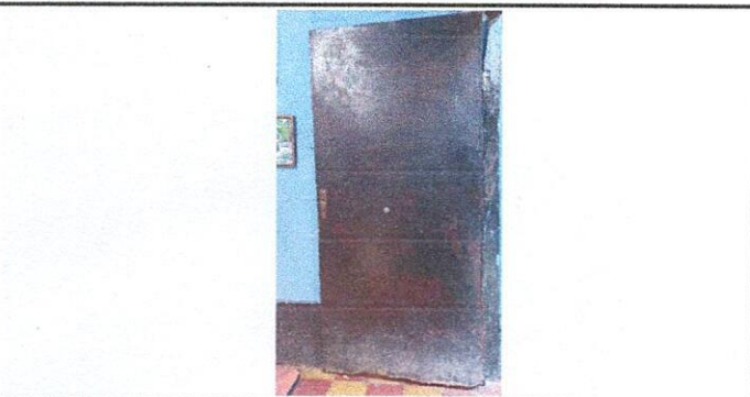
Foto 5: Cambio de puerta de playwood por puerta de metal de cuarto grado
