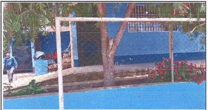
Foto 2: Cambio de malla en mal estado al rededor de la cancha
