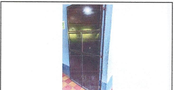
Foto 6: Reparación y cambio de chapas
