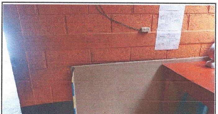
Foto 4: Construcción de Top de concreto
