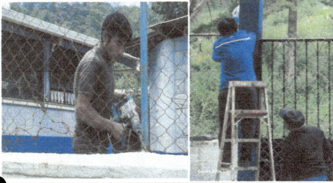
Foto 1: cambio de malla
