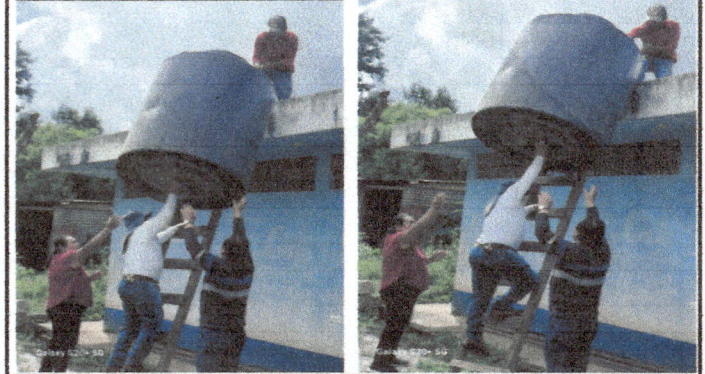
Foto 2: cambio de tinaco
