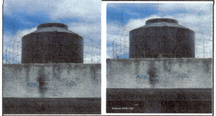
Foto 2: cambio de tinaco
