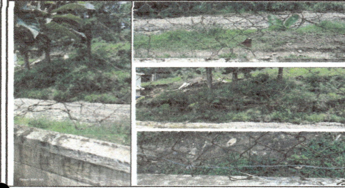
Foto1: cambio de malla
