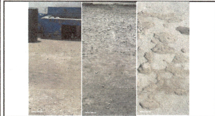
Foto 3: piso en corredor
