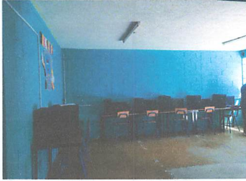
Foto1: Columnas de refuerzo área de Computación
