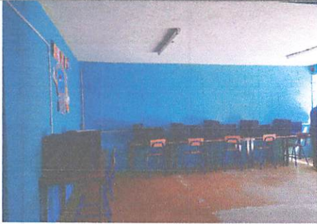
Foto1: Columnas de refuerzo área de Computación
