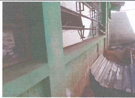
Foto 2: Impermealización de Bodega y Cocina
