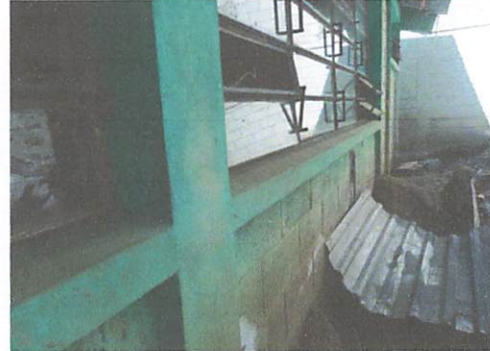
Foto 2: Impermealización de Bodega y Cocina
