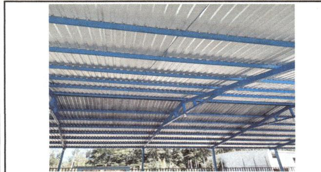
Foto 3: Costaneras, vigas y estructura completamente pintados
