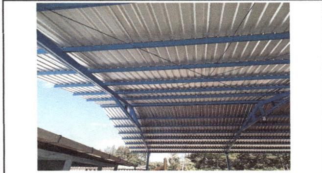
Foto1: Montaje de láminas completado
