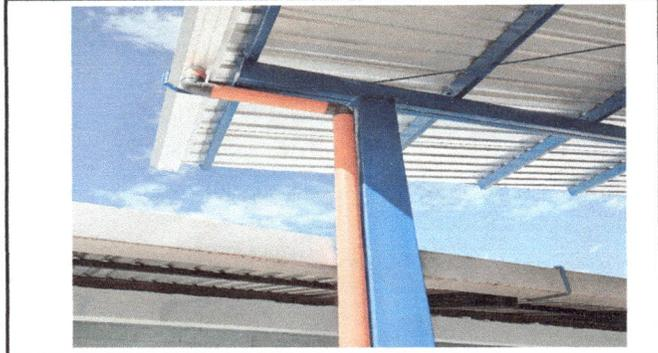
Foto 2: Instalación de canaletas u tubos de de bajada completado
