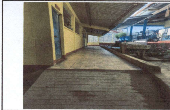
Foto 8: Piso pasillo 1 planta alta
