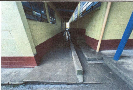
Foto 9: Piso pasillo 2 planta baja
