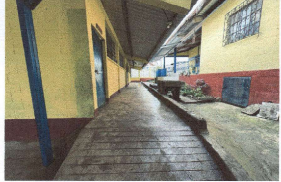
Foto 8: Piso pasillo 1 planta alta
