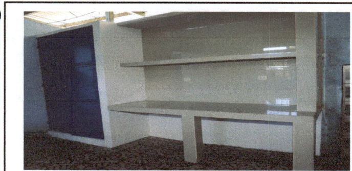
Foto 5: Mejoramiento de cocina de mesa y repisas de concreto e instalación de porcelanato
