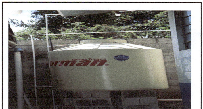
Foto 4: Cambio de tinaco pequeño por otro mas grande ya que no se da abasto para la distribución de agua.
